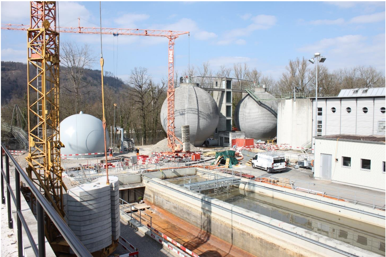
Baustelle Abwasserfiltration mit Faultürmen
